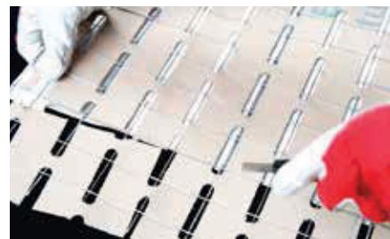
(a) Incisione del cartone in corrispondenza di due maglie di acciaio.
